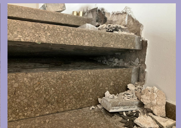
Mörtelfläche unter Trittstufe
