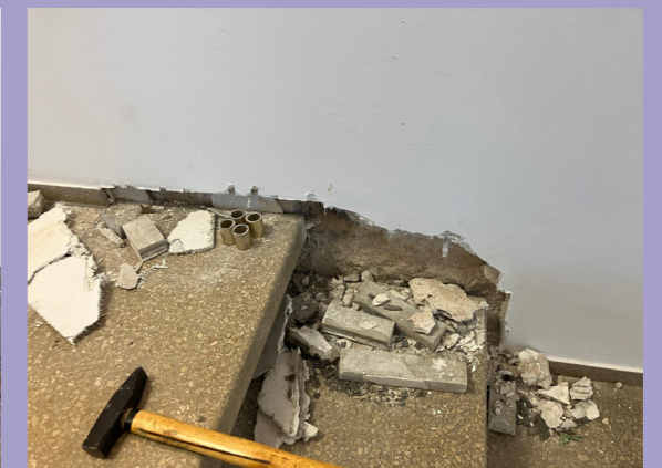
Entfernung der Sockelfliesen
