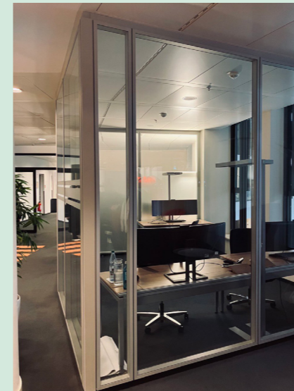
Bestands-Systemtrennwand im eingebauten Zustand
