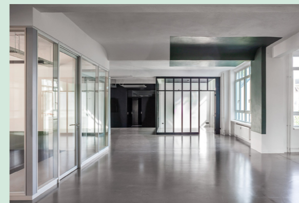
Aufbereitete und wiederverwendete Systemtrennwand
