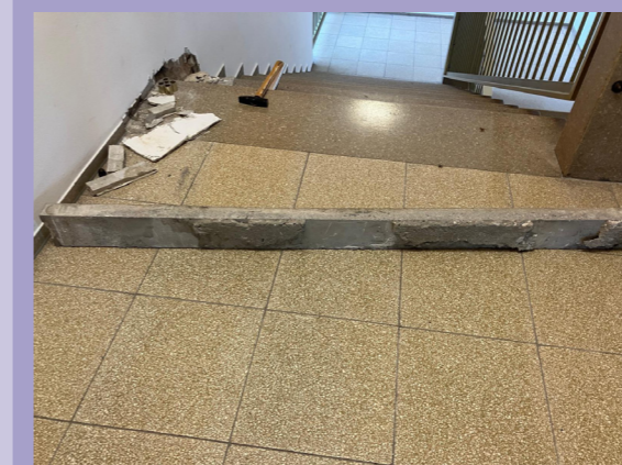
Ermittlung der Befestigung der Setzstufe: Punktuell aufgetragener Mörtel
