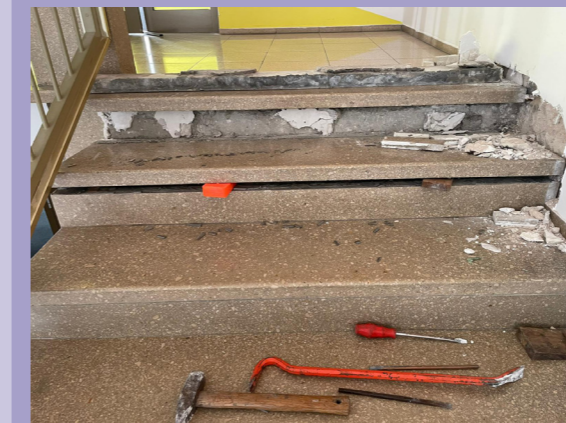
Proberückbau des Treppenstufen-Belags und Darstellung des verwendeten Werkzeugs
